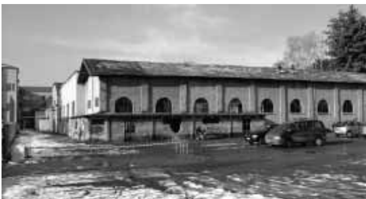
Gennaio 2005: prima della demolizione
