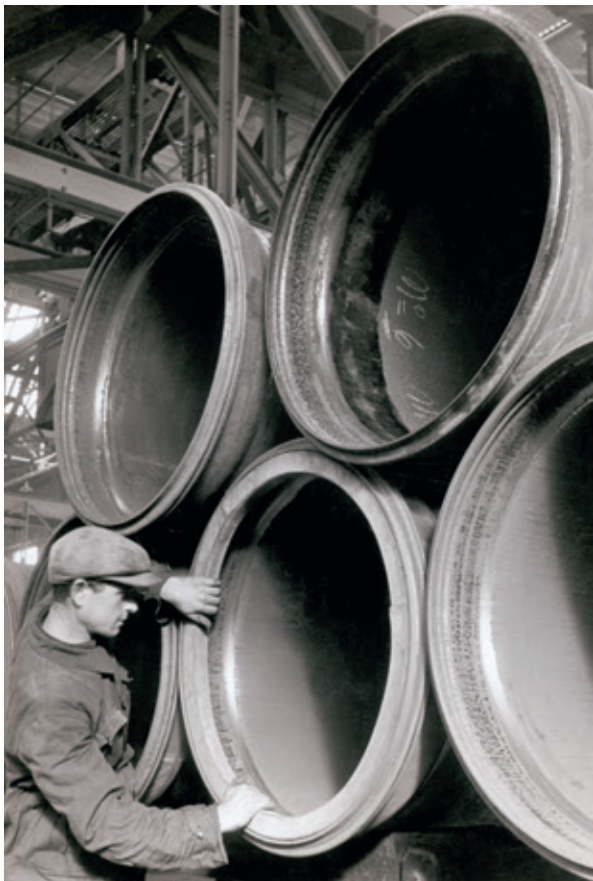
Figura 5: Due Reparti Produzione dei tubi a confronto dopo tre quarti di secolo. Il controllo visivo e quello al laser sono tecnologie distanti anni luce. A sinistra – Collaudo bicchieri (tubi) di grande diametro. Fine anni '30 (Foto: Bruno Stefani per Studio Boggeri, © Fondazione Dalmine) A destra – TenarisDalmine. LEMS (Controllo e revisione al Laser). Finitura dei tubi grandi – 2012 (Foto: Photo Studio U.V., © Tenaris)
