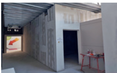
Lavori in corso sotto gli shed
