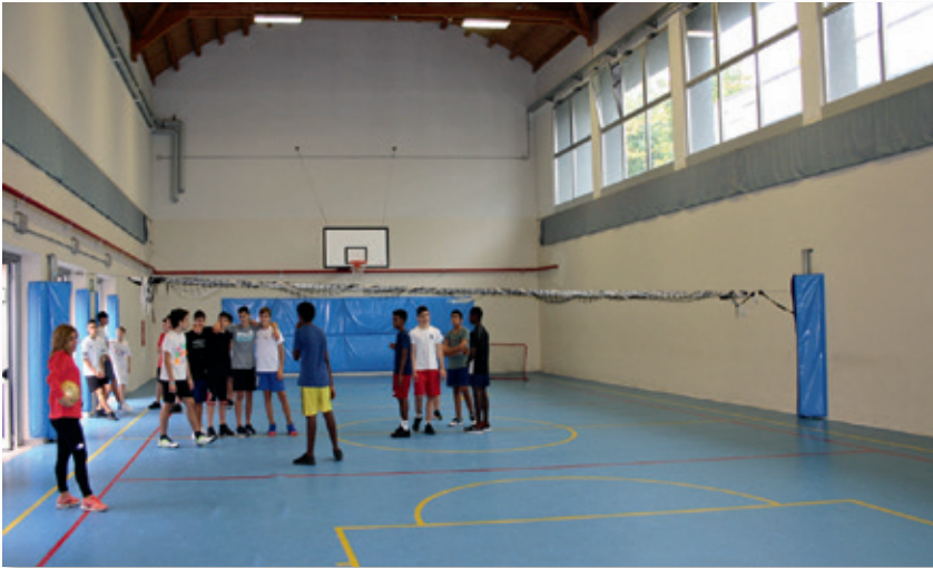
La Palestra 2 rinnovatissima. Il parquet ormai obsoleto sostituito dal taraflex e il tetto completamente rifatto hanno decisamente trasformato la vecchia palestra in qualcosa di moderno.
